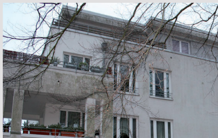
Musterfläche mit KefaTherm Extérieur an gedämmter Fassade
