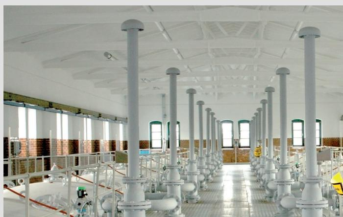
Mit KefaTherm behandelte Bollmannfilteranlage eines Wasserwerkes.
